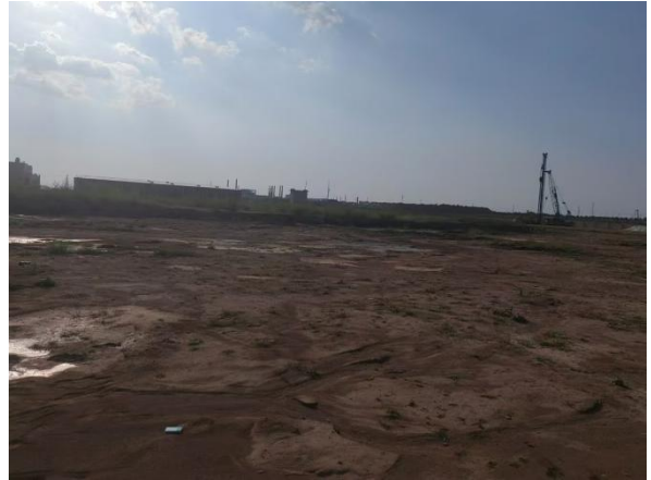
厂区内西北侧现状
