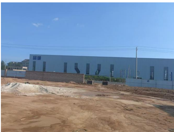
厂区南侧现状
