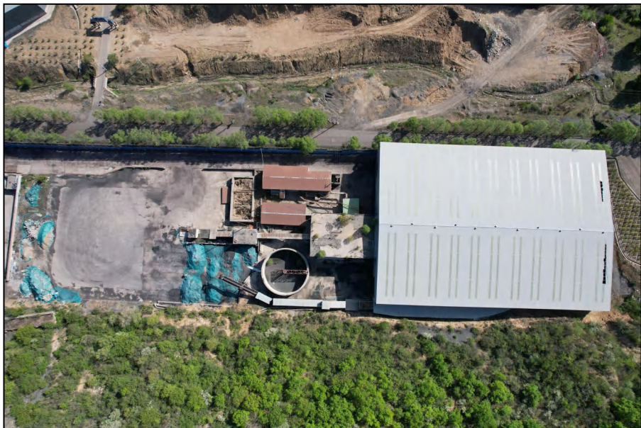
原 120 万吨洗煤厂厂区
