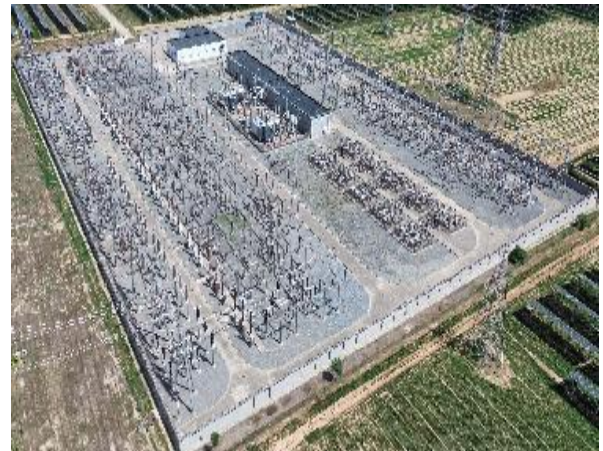
安居 220kV 变电站现状
