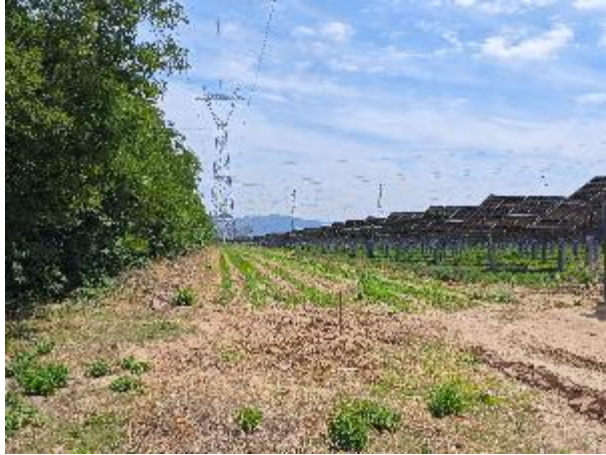
2#塔基及施工便道现状
