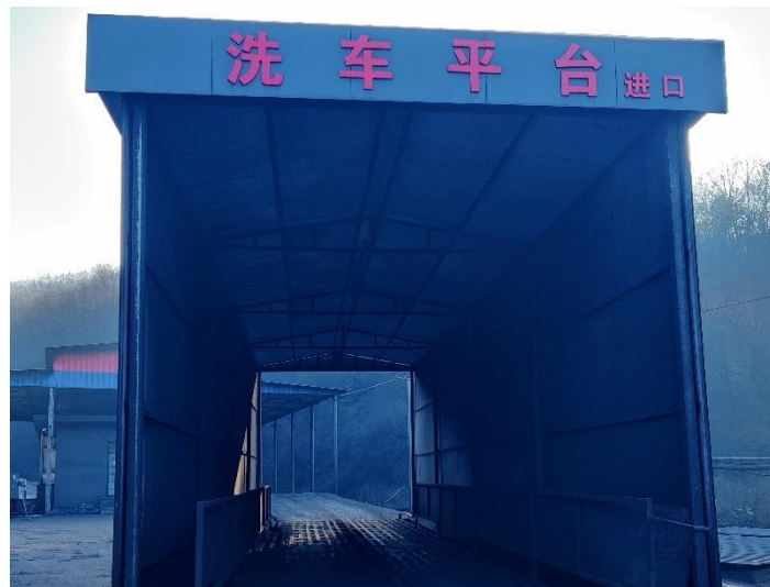
现有洗车平台（拆除重建）
