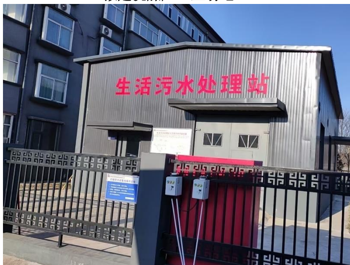
矿区生活污水处理站（依托）
