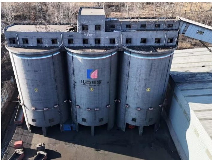
精煤仓（原煤仓改造）
