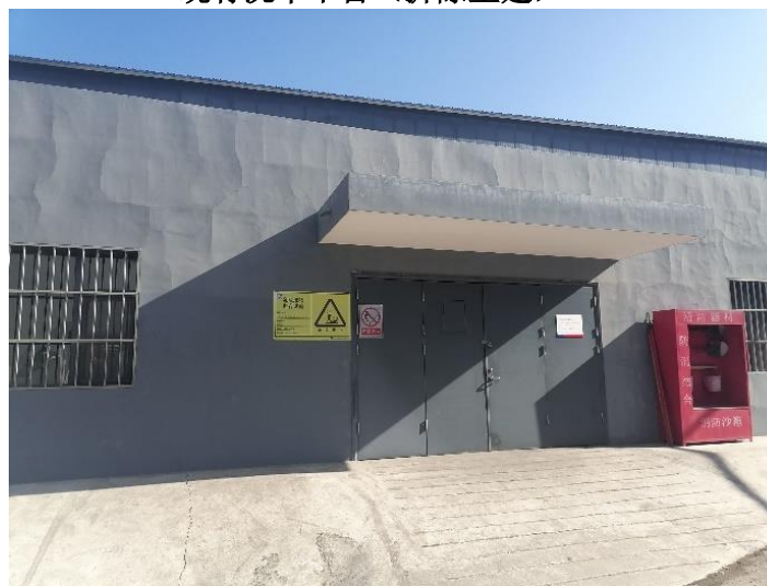
矿区危废贮存库（依托）
