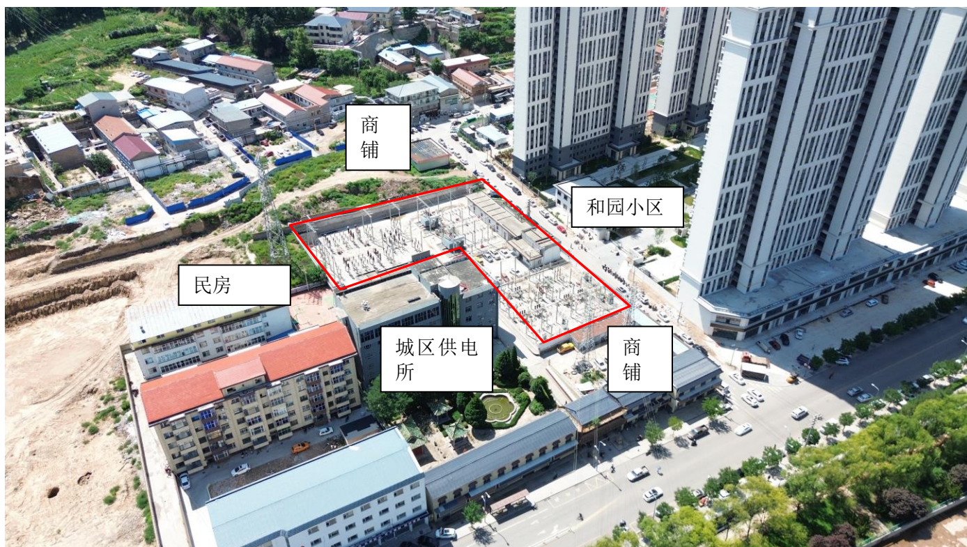
变电站及四邻
