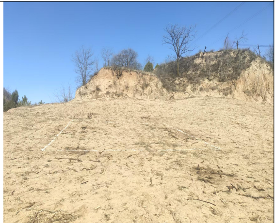
N3塔基占地现状
