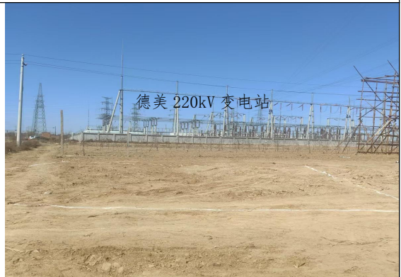
N6塔基占地现状
