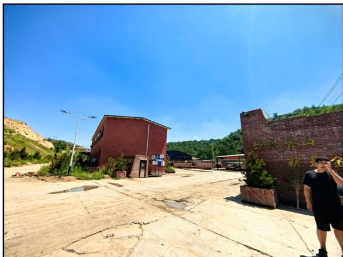
现有厂区大门（北侧道路）
