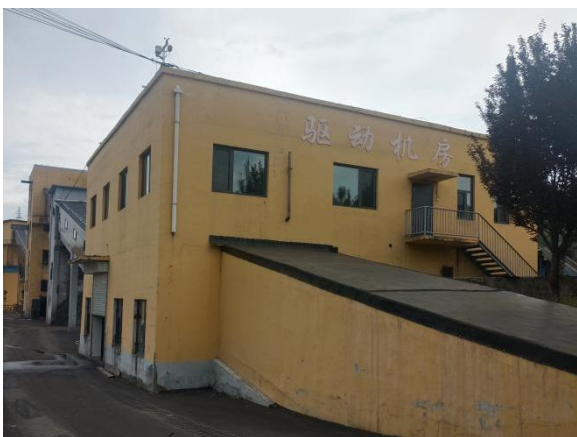
拟安装射线装置所在驱动机房
