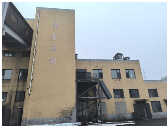
驱动机房西北侧筛分车间
