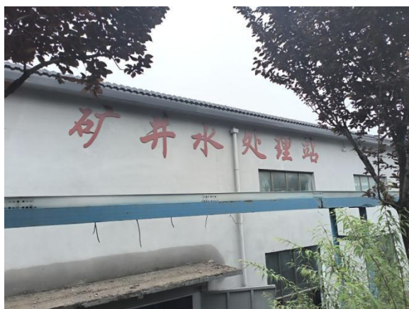
驱动机房西北侧矿井水处理站
