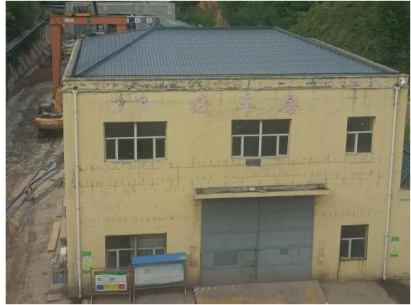
驱动机房东南侧绞车房
