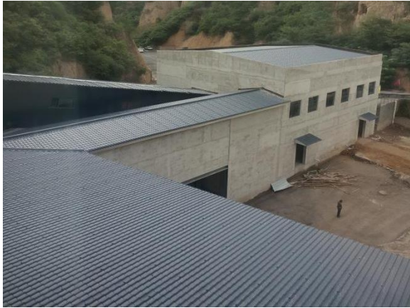
驱动机房东南侧主井井口房
