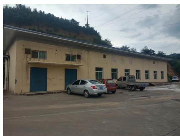
驱动机房东北侧通风机房
