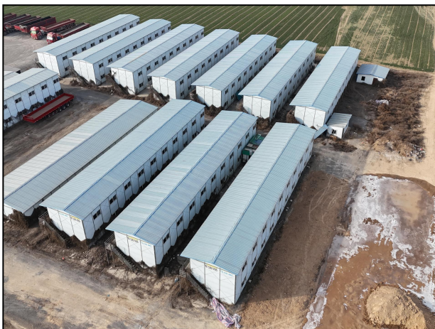
拟建线路南侧 20m 2 层平顶彩钢房
