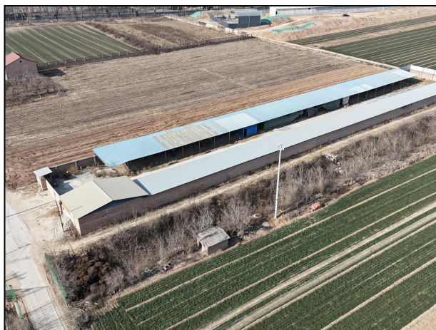
拟建线路西侧 23m 1 层平顶养殖场
