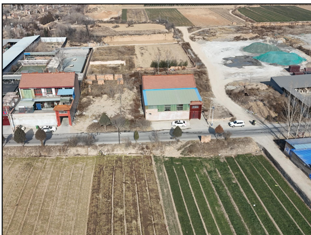
拟建线路西北侧 12m 2 层尖顶民房 拟建线路东南侧 8m 1 层平顶民房
