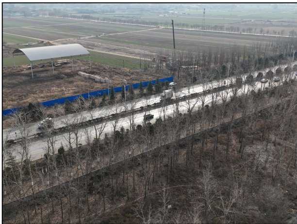
拟建线路跨越国道处
