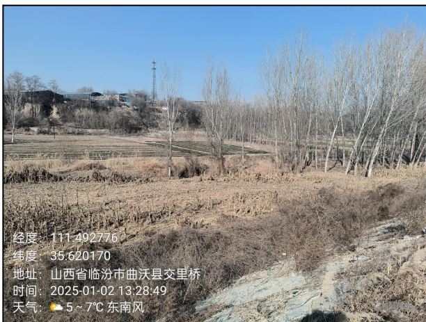
拟建线路跨越浍河处
