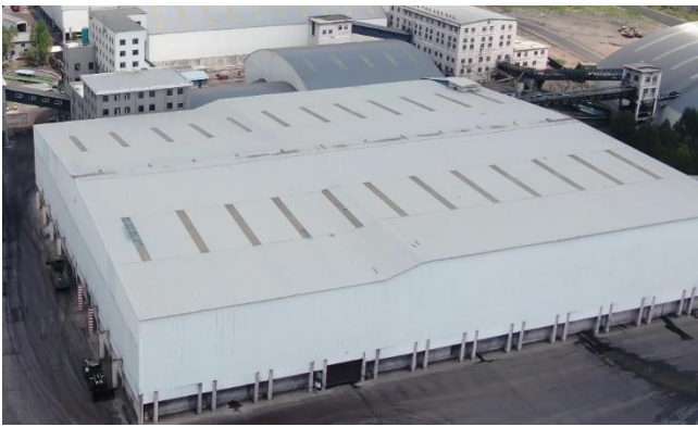
本次依托的精煤库
