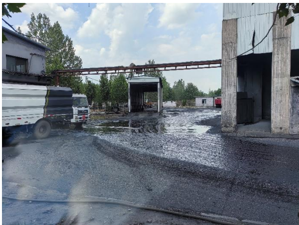
原煤进厂洗车平台
