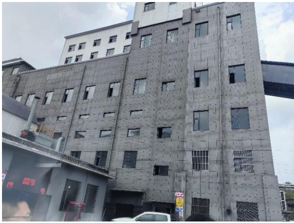
拟技改主洗车间
