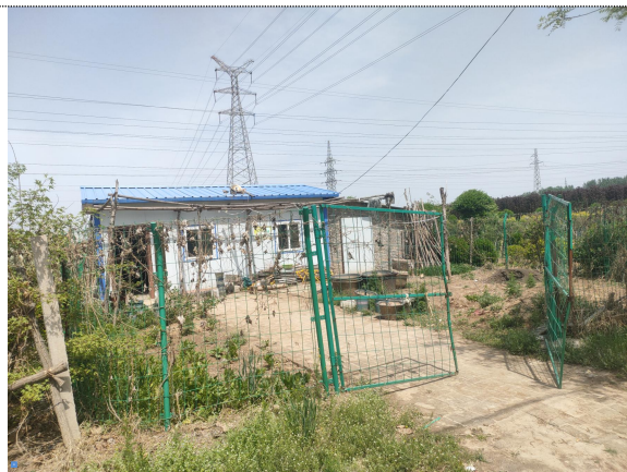
变电站东北侧 30m 临建民房
