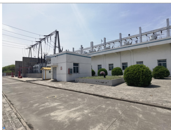
现有事故油池
