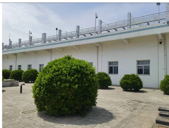
站内硬化、绿化工程
