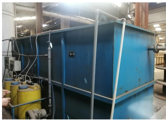
现有污水处理设施
