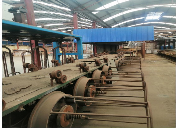
现有电镀车间镀锌丝生产线
