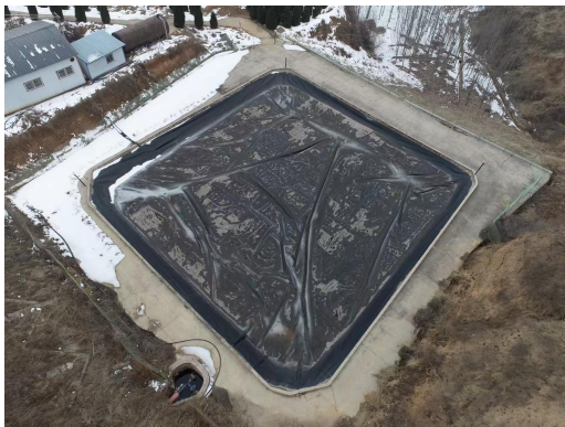
渗滤液处理站及调节池现状
