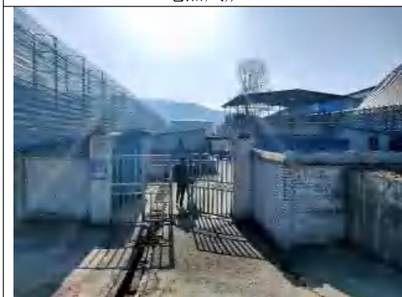
水处理站现状
