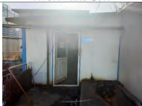
生活污水处理站
