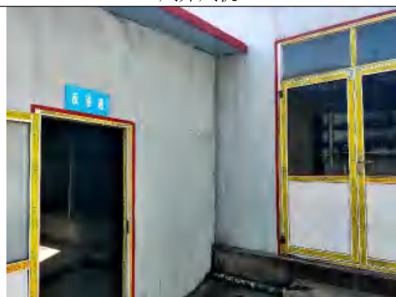
矿井水处理站反渗透车间
