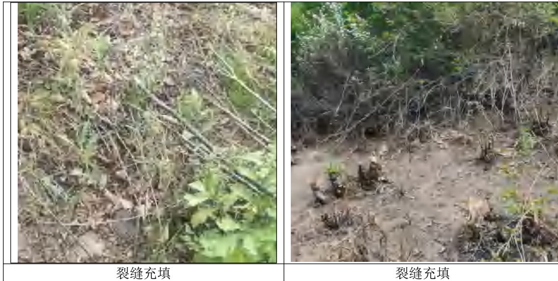
图 3.3-3 地面裂缝治理图
