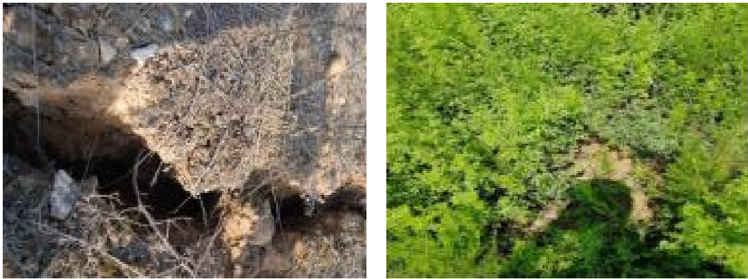
图 3.1-11 矿区裂缝治理前后对照图
