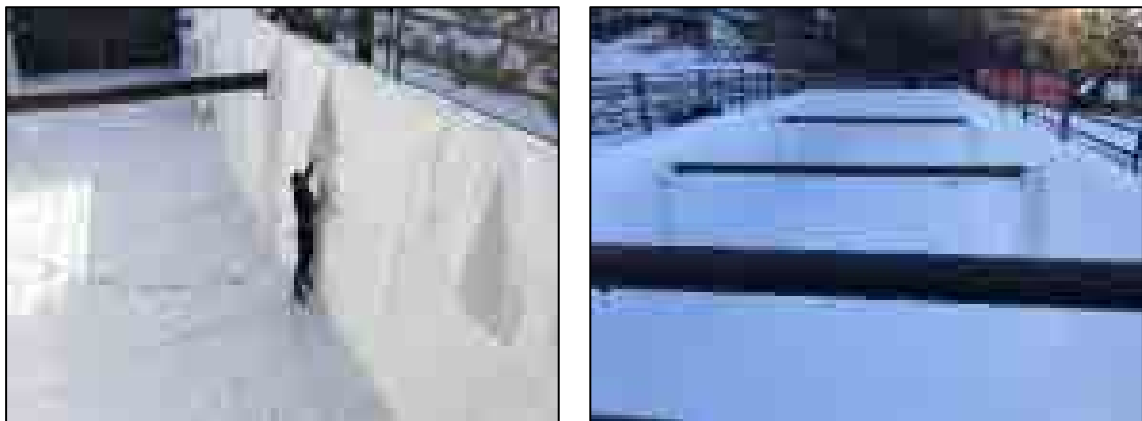
图 3.1-16 渣池土工布铺设图
