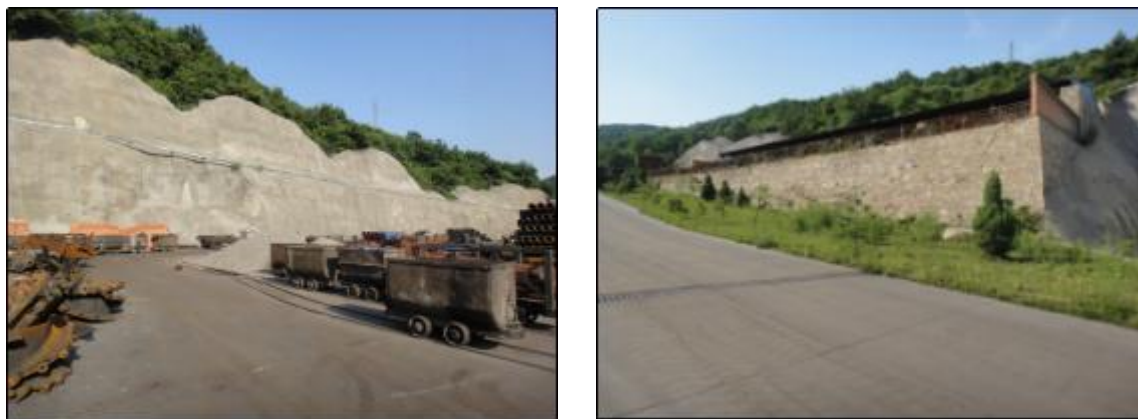
图 3.1-12 场地固坡工程
